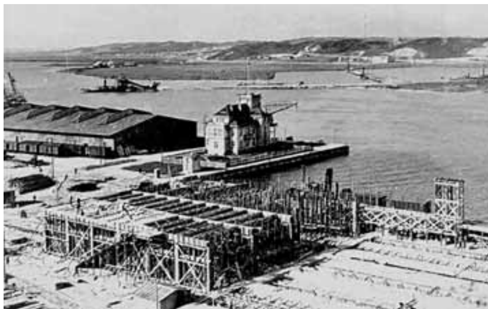
Kapitanat Portu i budowa mola pasażerskiego, początek lat 30.
