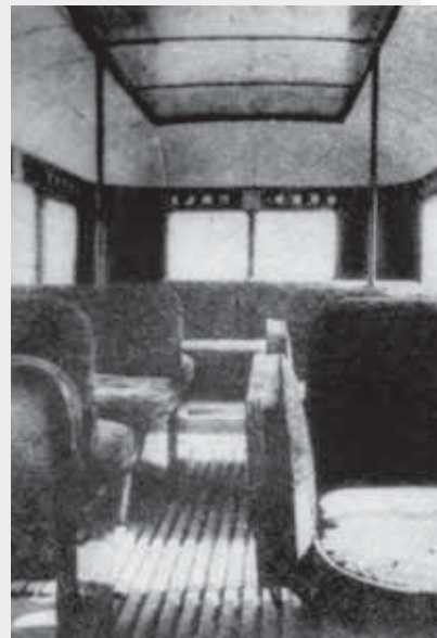
Wnętrze nadwozia konstrukcji M. Łukawskiego dostosowane do ciężarowego podwoziach Bedford
