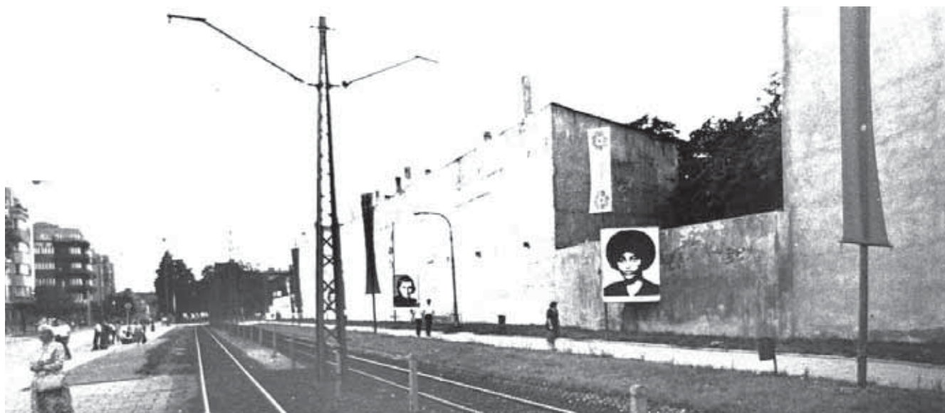
Takie ściany ukazywały się podczas budowania Trasy W-Z, w latach 70. Fragment, al. Mickiewicza.
