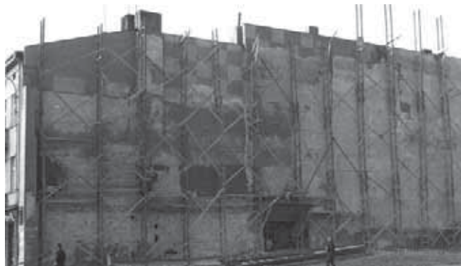
Ściana w trakcie przygotowań 1987 r.
